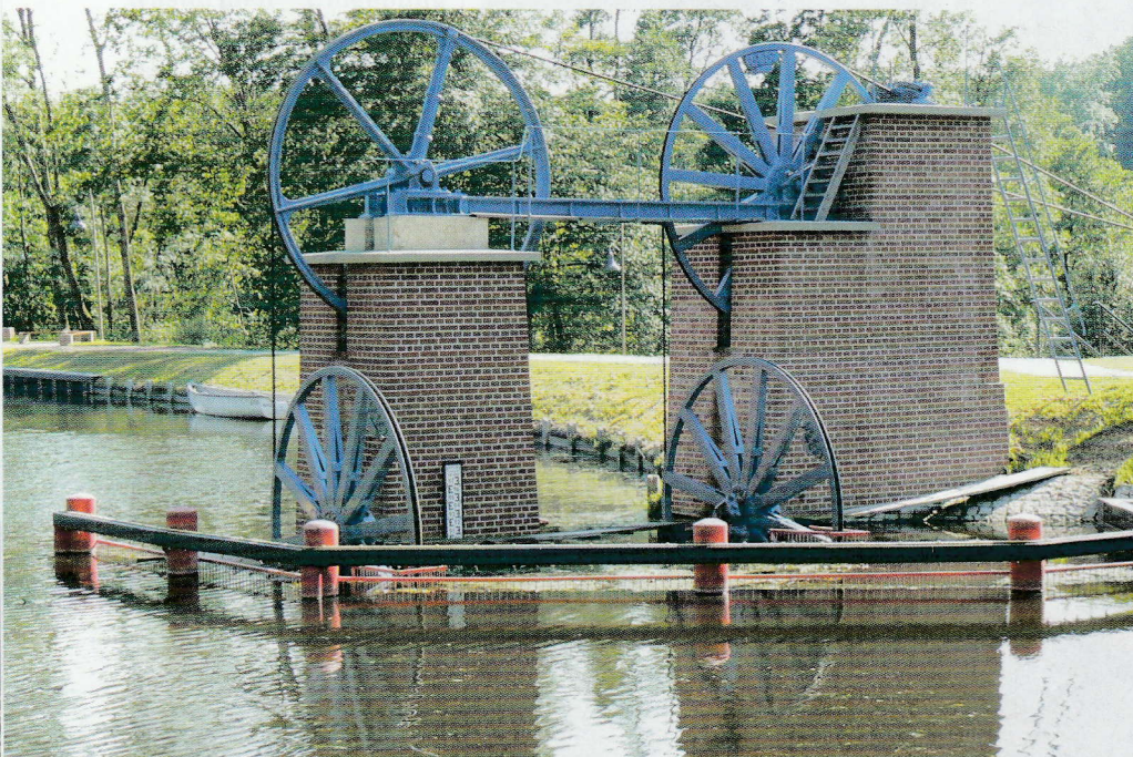
Seit 150 Jahren: Seilscheiben bei Buczyniec (Buchwalde) zum Umlenken der Stahlseile beim Bewegen der Gitterwagen
